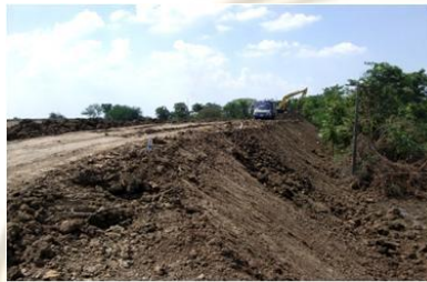
ก่อสร้างคันดินสูง 5 เมตรครึ่ง
