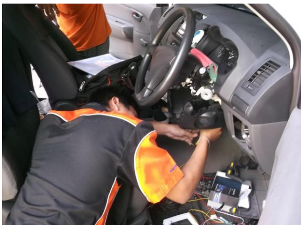
รูปภาพที่ 4.7 การติดตั้งอุปกรณ์
