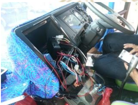
รูปภาพที่ 4.8 การติดตั้งอุปกรณ์ (ต่อ)
