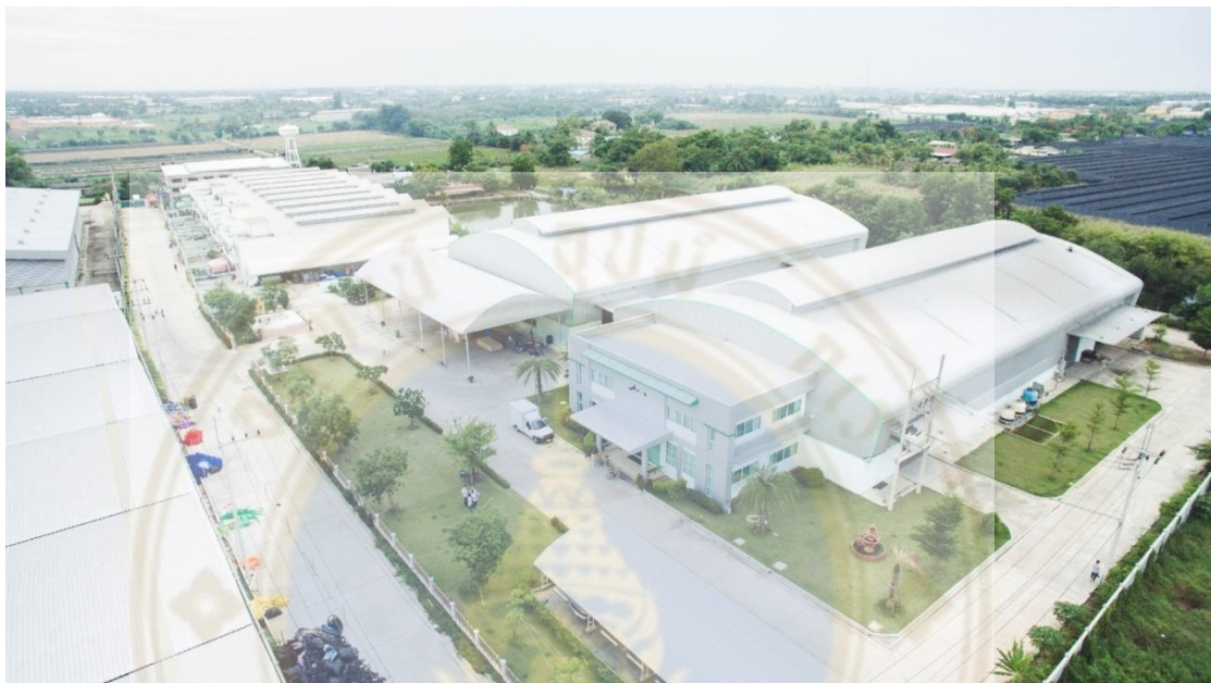
ภาพที่ 1.12 ภาพสถานที่ตั้ง และบริเวณโดยรอบของ บริษัทแอสต้าโฟมแอนด์รีบบเบอร์ จำกัด ที่มา: บริษัทแอสต้าโฟมแอนด์รีบบเบอร์ จำกัด, 2561
