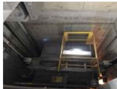
3. การติดตั้งลิฟต์
