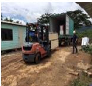
1. ต้ายหินก้อนจากตู้คอนเทนเนอร์ไปที่หน้าไซต์งาน
