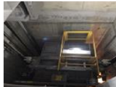
3. การติดตั้งลิฟต์
