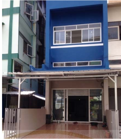
ภาพที่ 5.1 แสดงอาคารสำนักงาน Above the Mount
