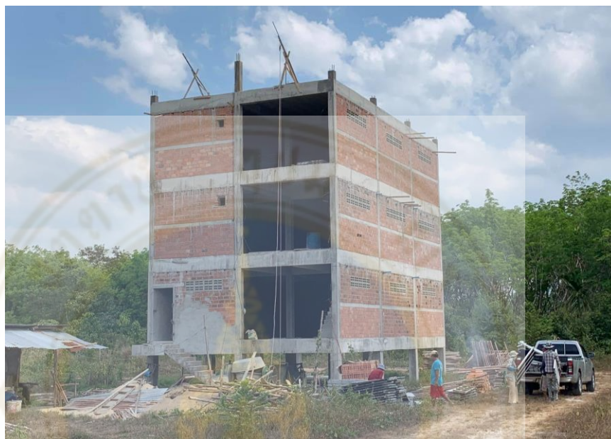
ภาพที่ 1.1 ภาพการก่อสร้างอาคารคอนโดนก
