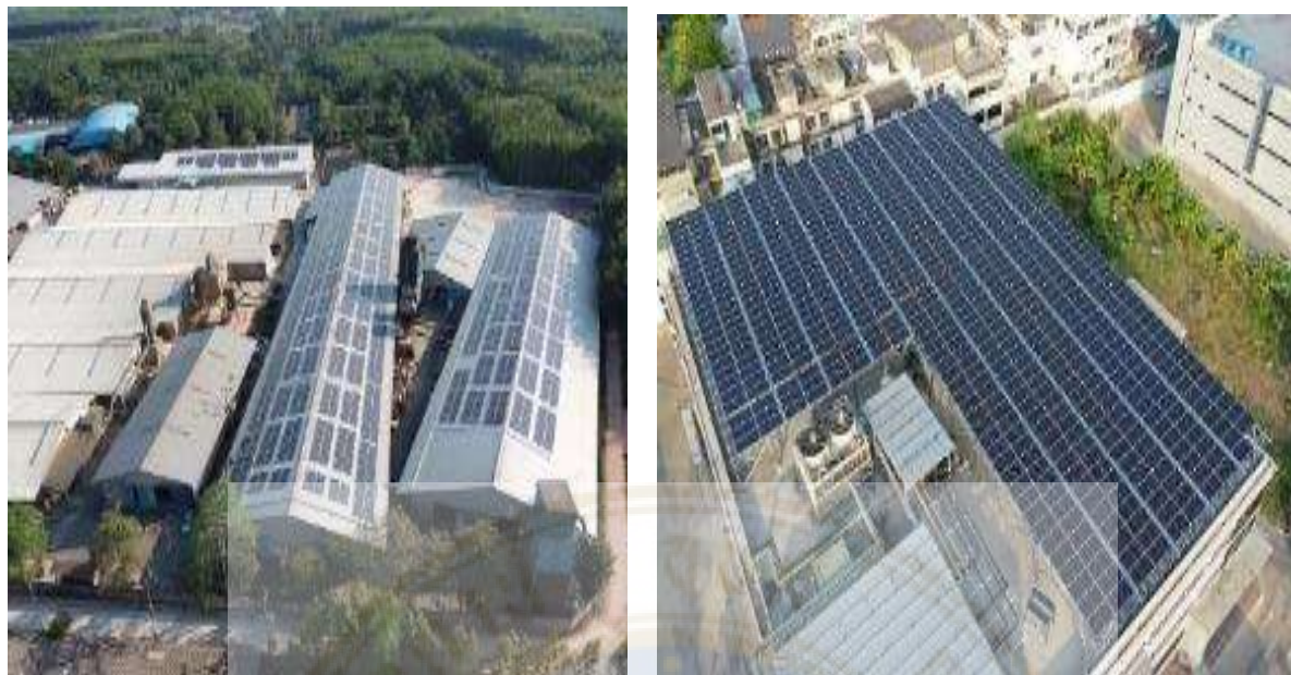
ภาพที่ 1.4. ตัวอย่างการติดตั้งแผงเซลล์แสงอาทิตย์ (solar cells)
