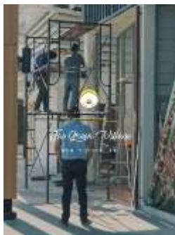
รูปที่ 3.5 แสดงการตกแต่งและก่อสร้างร้านชาลาเปาและเบเกอรี่ฟินิกซ์ ลาวาในสถานบริการน้ำมัน
