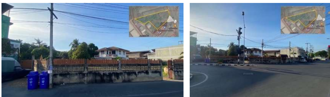
ภาพ 3.9 ภาพบริเวณรั้วด้านหน้าที่ดินติดถนน. ที่มา ผู้จัดทำ
