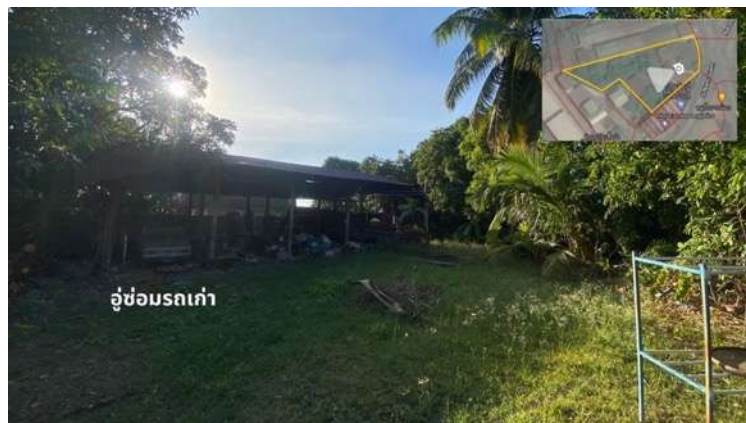
ภาพ 3.12 ภาพโครงสร้างอุ้งรกเก่า บริเวณด้านที่ดินบริเวณด้านหลังโครงการ. ที่มา ผู้จัดทำ
