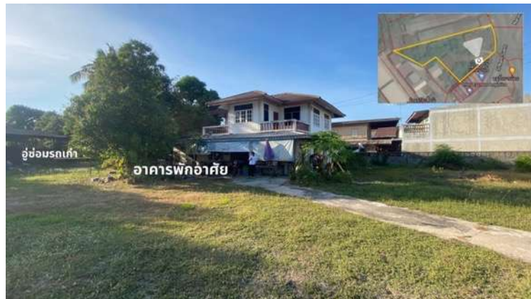
ภาพ 3.13 ภาพอาคารบ้านพักอาศัย 2 ชั้นภายในพื้นที่โครงการ. ที่มา ผู้จัดทำ
