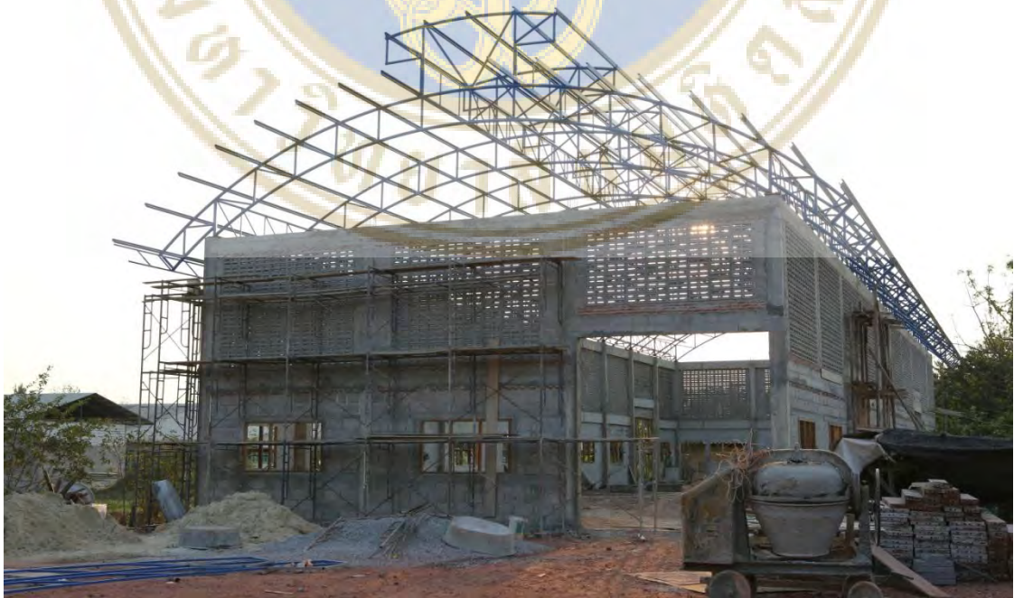
รูปภาพ 4.8 อาคารทอผ้าหลังที่ 3 ที่กำลังก่อสร้าง
