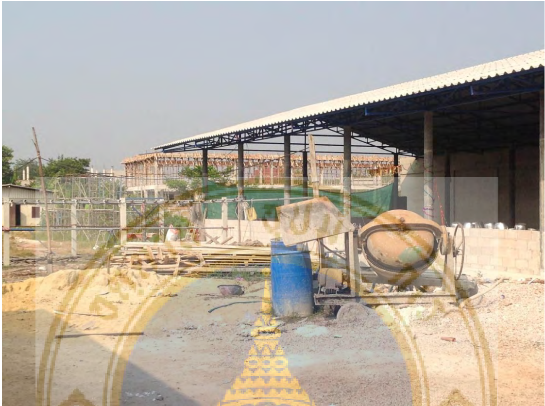
รูปภาพ 4.7 อาคารทอผ้าหลังที่ 2 ที่กำลังก่อสร้าง
