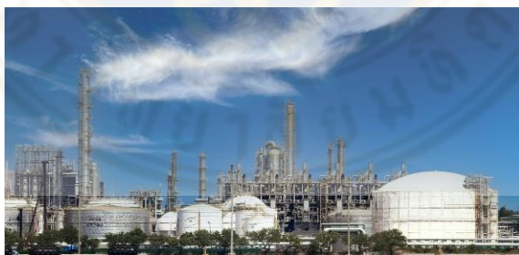
รูปที่ 2.7 โรงกลั่นน้ำมัน บริษัท ไออาร์พีซี จำกัด (มหาชน) จ.ระยอง
