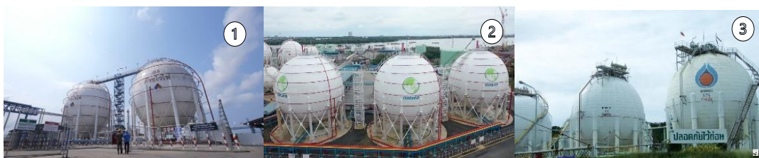
รูปที่ 2.8 คลังก๊าซ สยามแก๊ส (ภาพที่ 1) คลังก๊าซ เวิร์ดแก๊ส (ภาพที่ 2) ทั้ง 2 แห่ง ตั้งอยู่ที่ บางปะกง จ.ฉะเชิงเทราคลังก๊าซ ปตท. คลังก๊าซบ้านโรงโป๊ะ จ.ชลบุรี (ภาพที่ 3)
