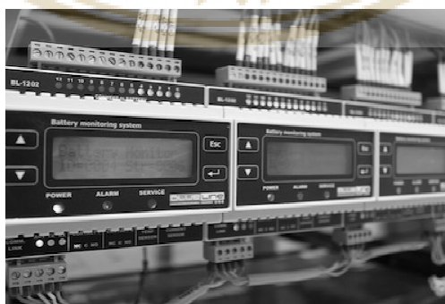
ภาพที่ 1.2: แสดงอุปกรณ์ตรวจวัดและแจ้งเตือนคุณภาพแบตเตอรี่ที่ถูกติดตั้งและกำลังทำงาน (ที่มา: นายไพฑูรย์ ชัยโชติอนันต์)
